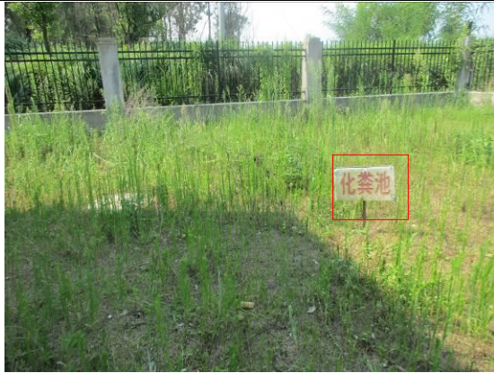
生活办公区设置的化粪池
